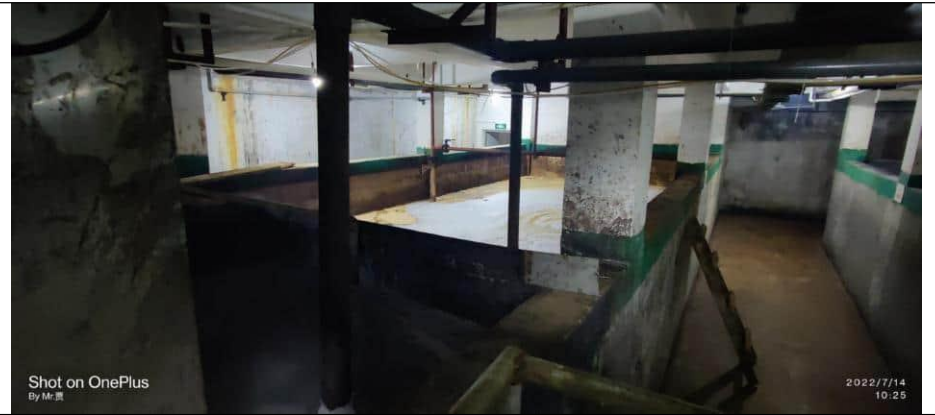
污水预处理站位于下沉式地下室内，各池体为接地池体
